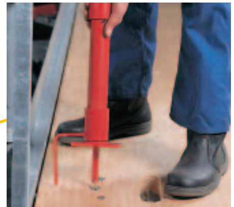
Päätykaidetolppa FBP kierretään niveltyötasossa oleviin kiinnityskohtiin (DW15) ja lisätään puusoirot kaiteiksi.
