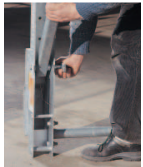
Liitintapit on kiinnitetty vinotukeen vaijereilla.
