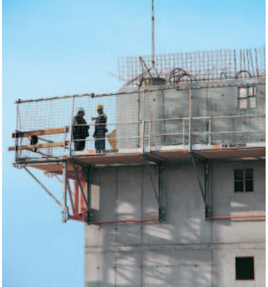
Nivelytason kanssa käytetty turvaverkko.
