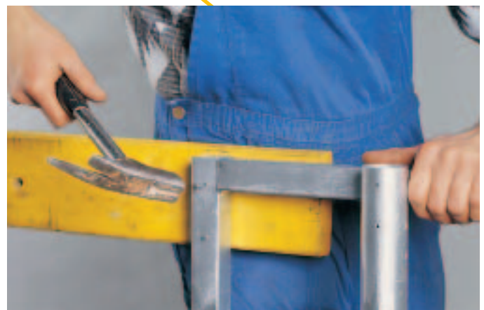
Kaidekehässä olevat reiät mahdollistavat kaidepuiden naulaamisen.
