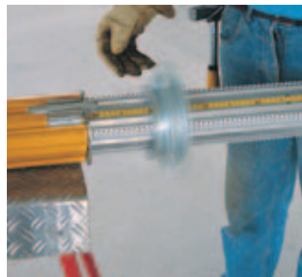
Mutterin täysi kierros merkitsee 36 mm:ä (Kolminkertaisesti vanhaan holvitukeen nähden).
