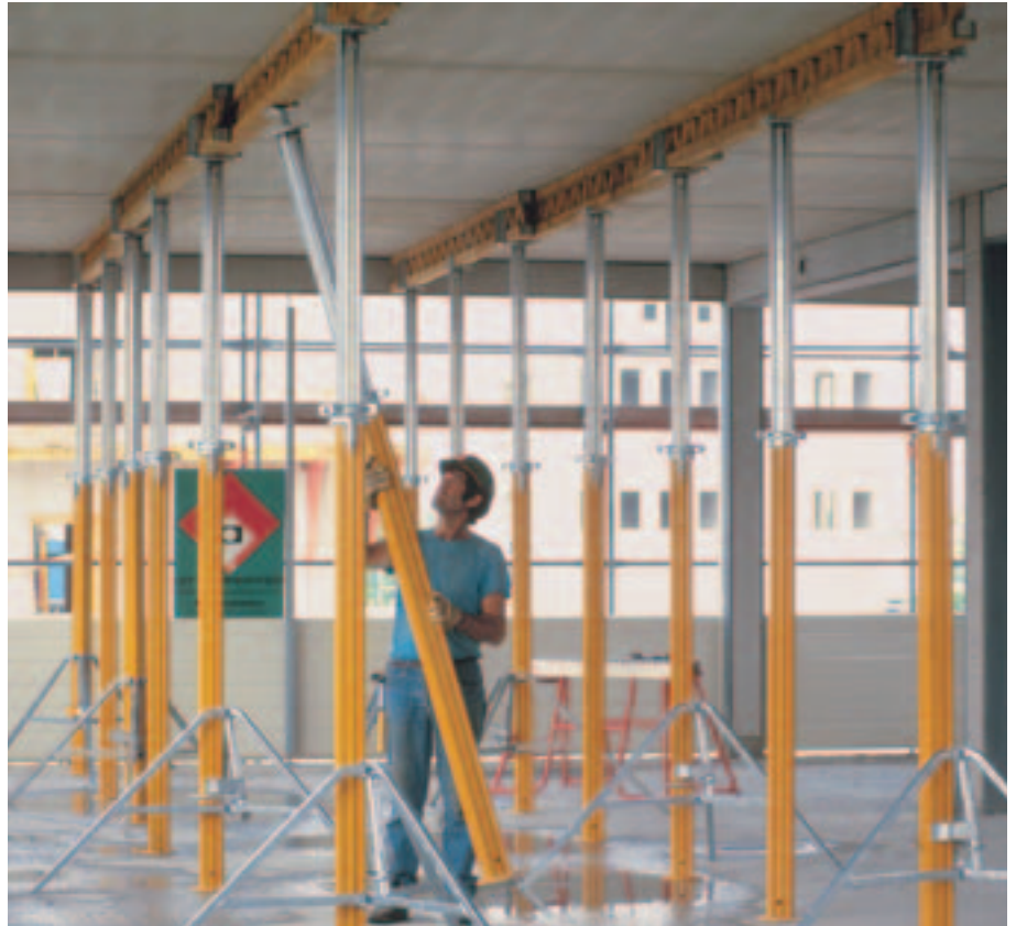
Yksi mies käsittelee MP 350:aa vaivattomasti. Paino 18,8 kg tekee tämän mahdolliseksi.
