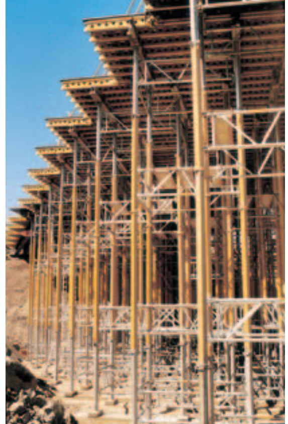
MULTIPROP tornit, korkeus 8,80 m, tukemassa pöytämuotteja.
