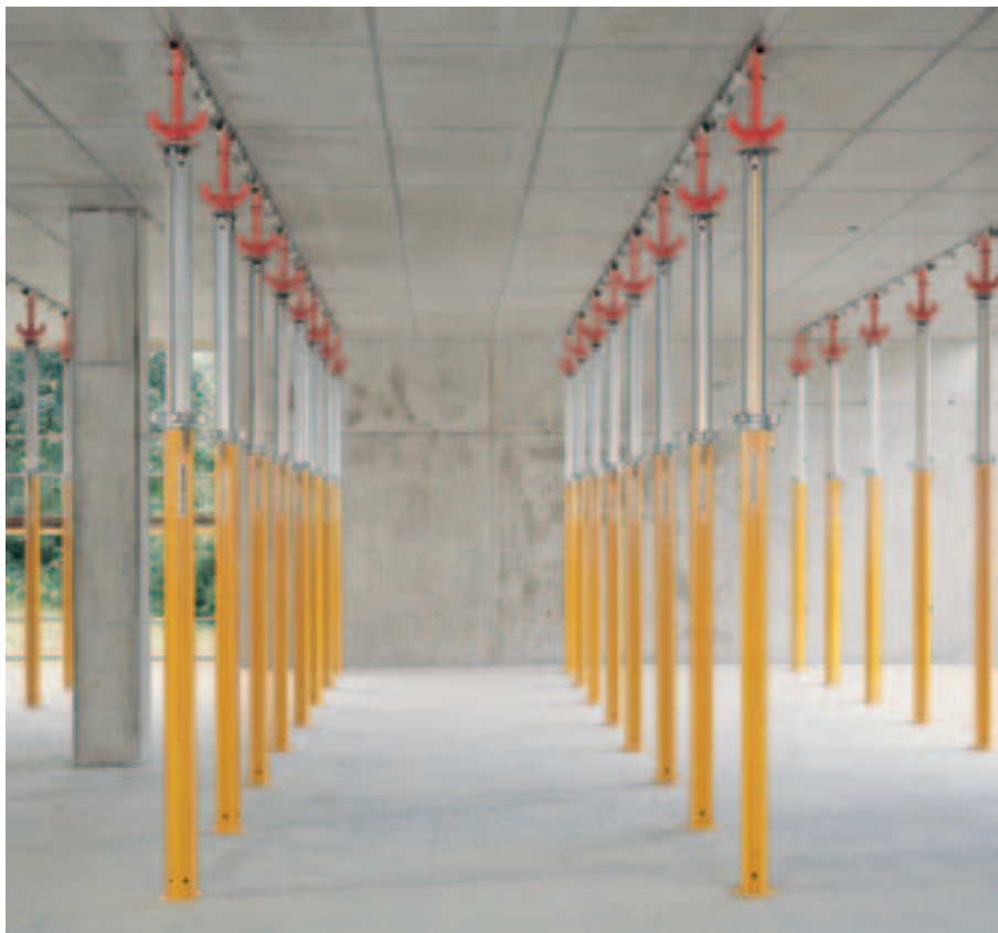
MULTIPROP 350 ja SKYDECK jälkituennassa. Tukia vain 0,29 kpl/m 2 , vaikka holvin paksuus on 40 cm.
