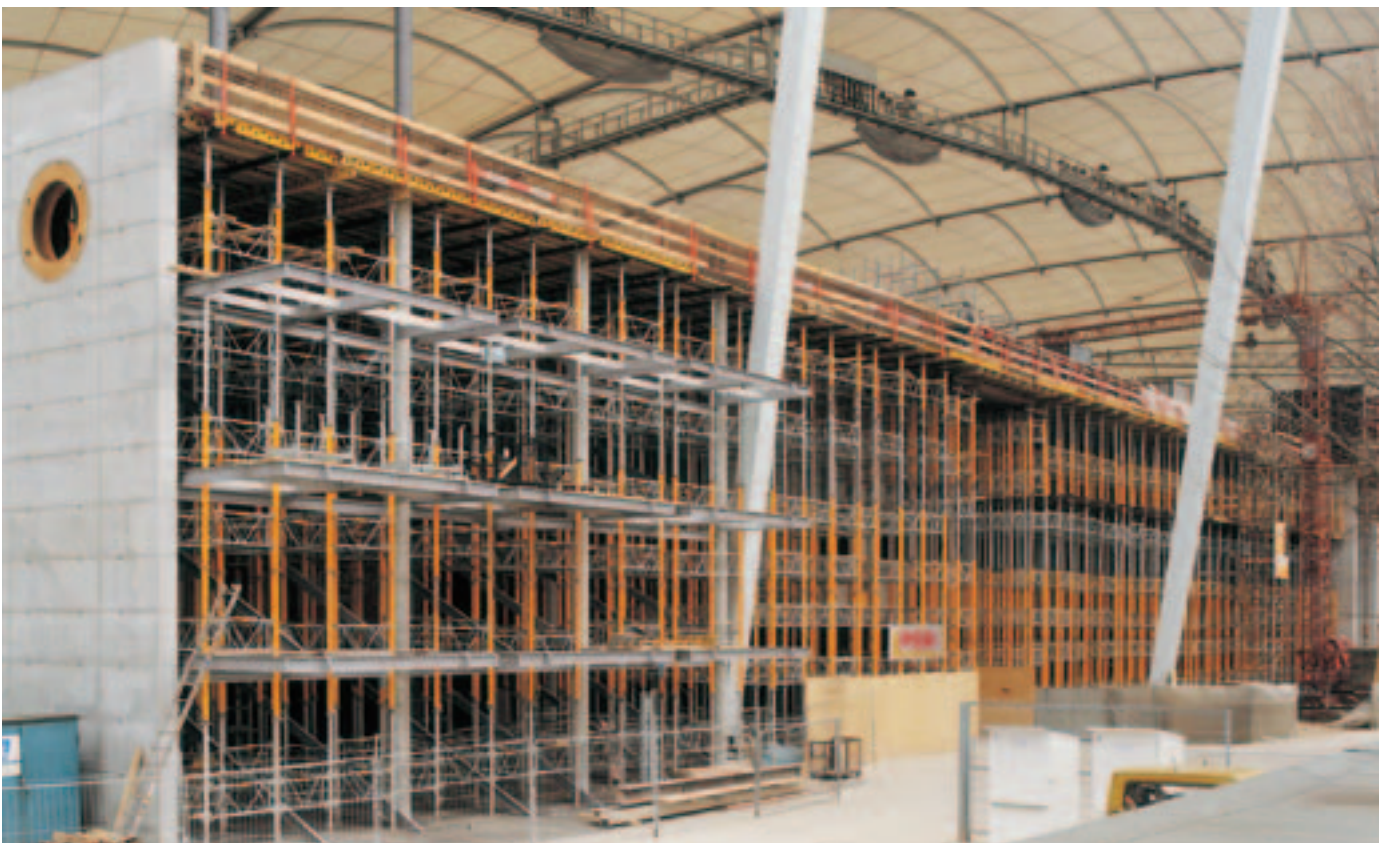
Järeä 3500 m 2 :n holvi on tuettu 14,0 m korkeilla MULTIPROP tukitorneilla. Tornit on voitu sijoittaa kätevästi myös teräsrakenteiden väliin.
