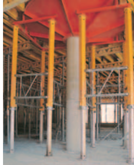
MULTIPROP 350 kehineen sienen muotin tuennassa.
