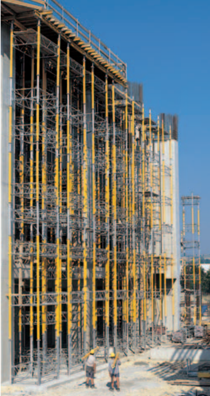
20 m korkeat MULTIPROP tukitornit tukemassa holvin ulokkeellista reunakaistaa.
